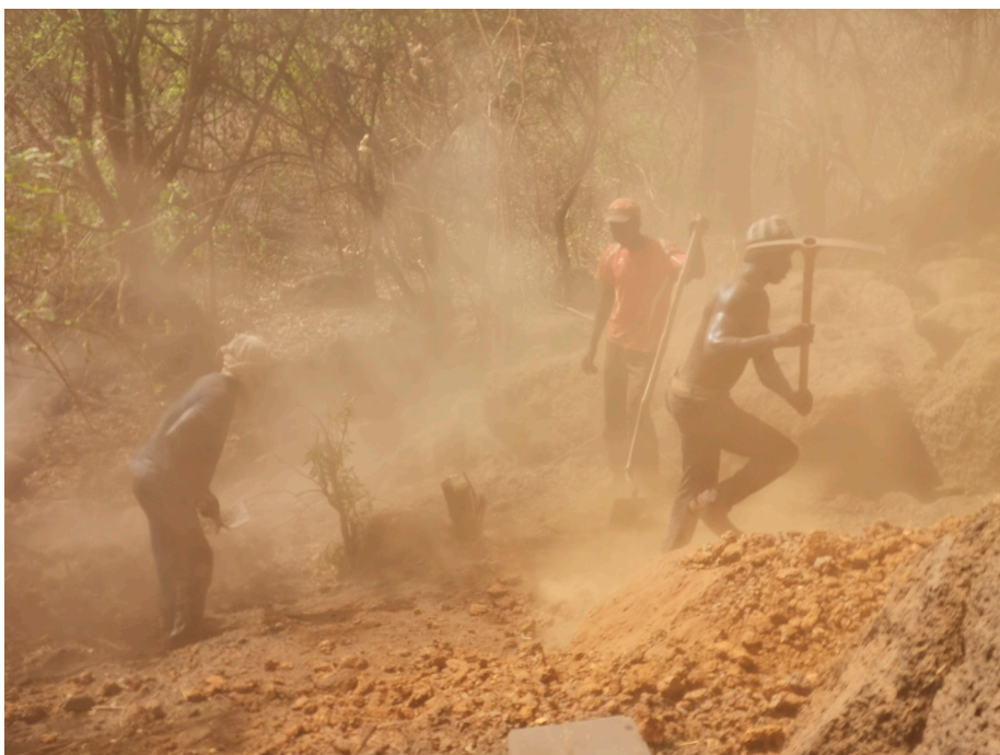
28 avril 2020. Terrassement du site du futur haut-fourneau : la falaise est nettoyée avec l'aide d'orpailleurs mis au chômage par la pandémie de Covid-19, payés 7 500 CFA la journée (environ 11 euros).
